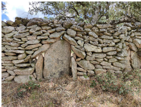
Imagen 4. Ejemplo de muros de piedra en cajón, combinación con piedras hincadas, Pino del Oro (Zamora), Fuente: Elaboración propia.
