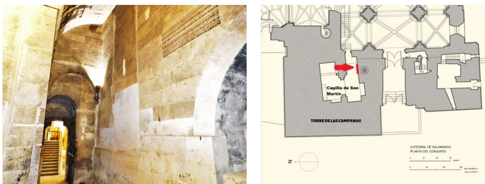
Fig. 6: (izq.) Lienzo meridional de la Capilla de San Martín en el que se localiza el posible acceso elevado a la Torre de las Campanas © Ilmo. Catedral de Salamanca; (dcha.) Localización en planta del posible acceso elevado a la Torre de las Campanas desde el interior de la Capilla de San Martín sobre plano de ©V. Berriochoa.
