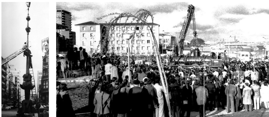
Fig. 15. Colocación de La Farola en 1979 y la locomotora en 1978.
