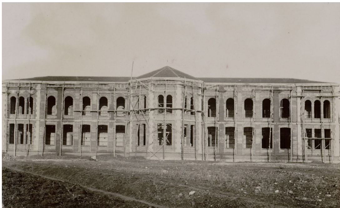
Figs. 3 y 4. Edificio durante la construcción. AGA. (05). 115.000. 31/8388.
