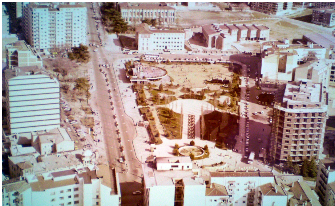
Fig. 17. Parque de las Avenidas cerca de 1980 (AHPZa, catastro de urbana, caja 1018).
