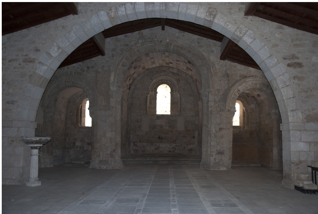
Fig. 1. Estado de la cabecera de la iglesia de Santo Tomás tras la restauración de 2008. Fuente: http://www.romanicozamora.es/
