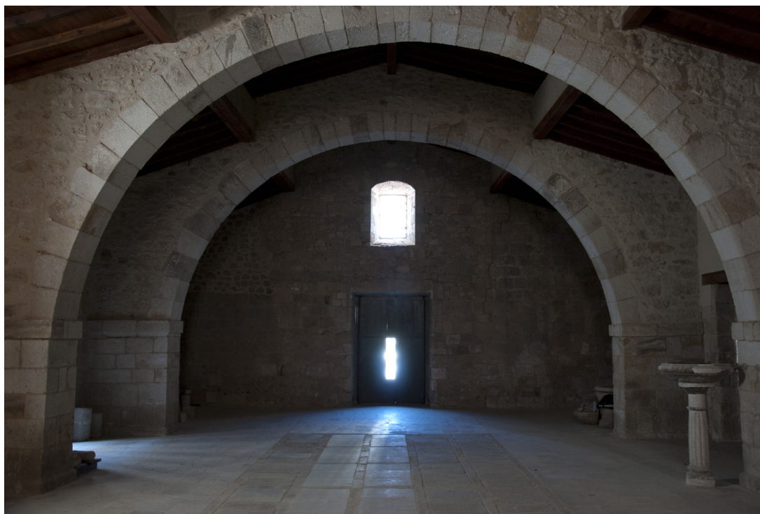
Fig. 3. Tomás tras la restauración de 2008. Fuente: http://www.romanicozamora.es/
