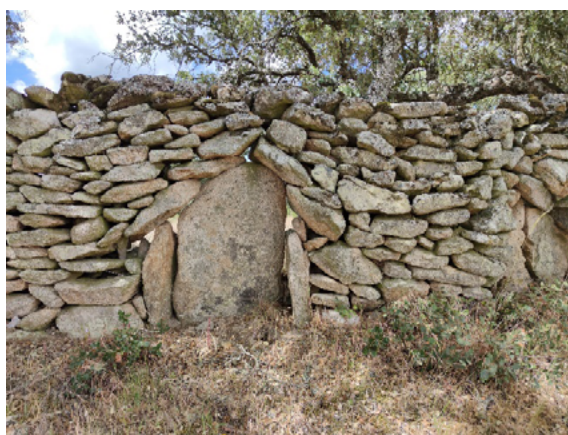
Imagen 4. Ejemplo de muros de piedra en cajón, combinación con piedras hincadas, Pino del Oro (Zamora), Fuente: Elaboración propia.
