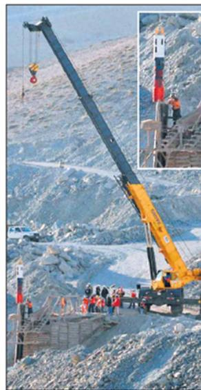
Con una grúa similar a ésta, la cápsula será introducida al ducto de 66 cm de diámetro para ser forzada con tubos de metal (en la foto) por donde subieron los mineros.
