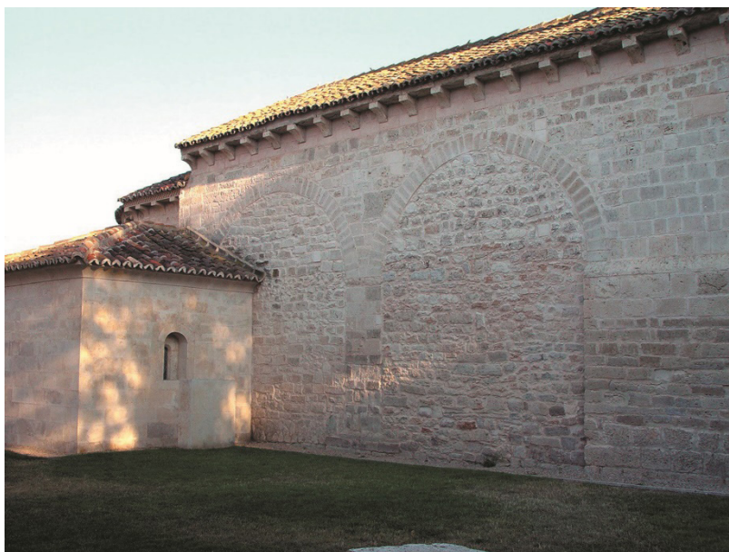
Figura 3. Estado actual de los arcos cegados del lienzo norte de la iglesia, junto a la nueva sacristía. Elaboración del autor.
