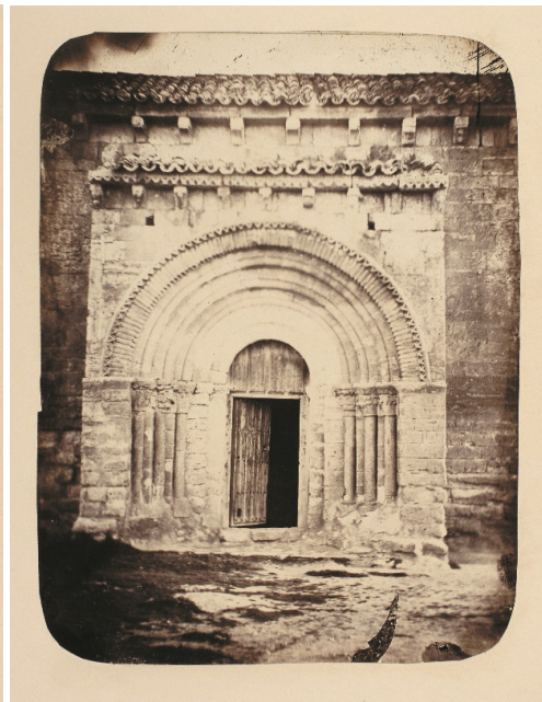
Figura 7. Estado de una de las ventanas del ábside de la iglesia antes de su restauración. 1868. RABASF, Archivo-biblioteca, Fotografías, caja 27, exp. 287, fot. 2165.
