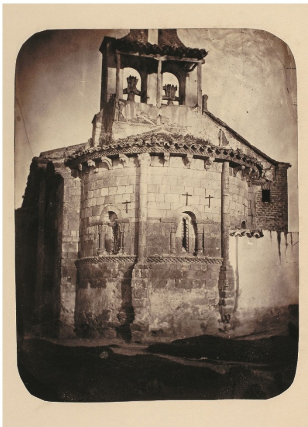
Figura 4. Estado del ábside, espadaña y construcción de ladrillo adosada al lado norte antes de la restauración de la iglesia. 1868. RABASF, Archivo-biblioteca, Fotografías, caja 27, exp. 287, fot. 2162.
