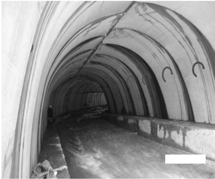
Fig. 4a. Desplazamientos, giros y filtraciones de agua
