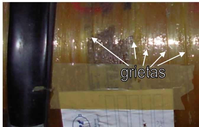
Fig. 3. Grietas observadas en cilindros de GNC Tipo 2, en condiciones normales.
