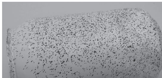
Fig. 13. Superficie cilíndrica dañada.
