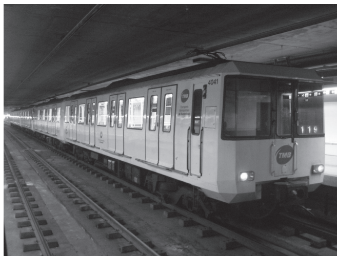
Fig. 3. Vía bibloque. Línea 1 del Ferrocarril Metropolitano de Barcelona.
