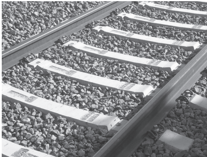
Fig. 1. Vía convencional, con balasto y traviesas de hormigón monobloque.
