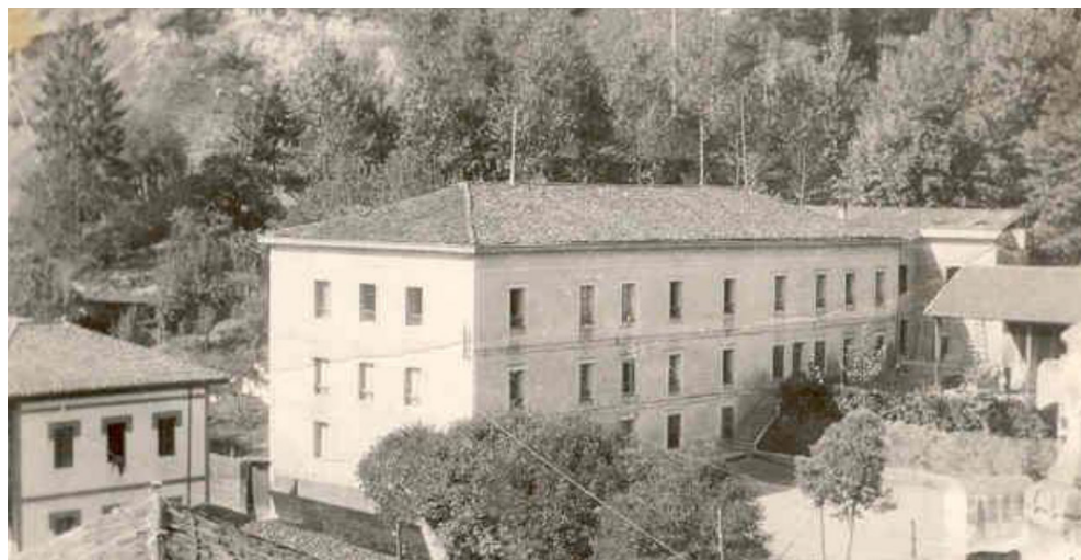
Imagen 1. Edificio del colegio San Viator de Infiesto (ACSV).
