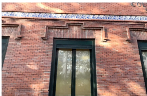
Figura 13. Detalle de la fachada. Imagen actual.
