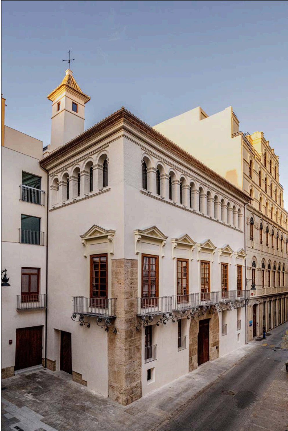
FIGURA 2. PALACIO DE LOS VALERIOLA EN LA CALLE DEL MAR, VALENCIA. Fotografía del Centro de Arte Hortensia Herrero
