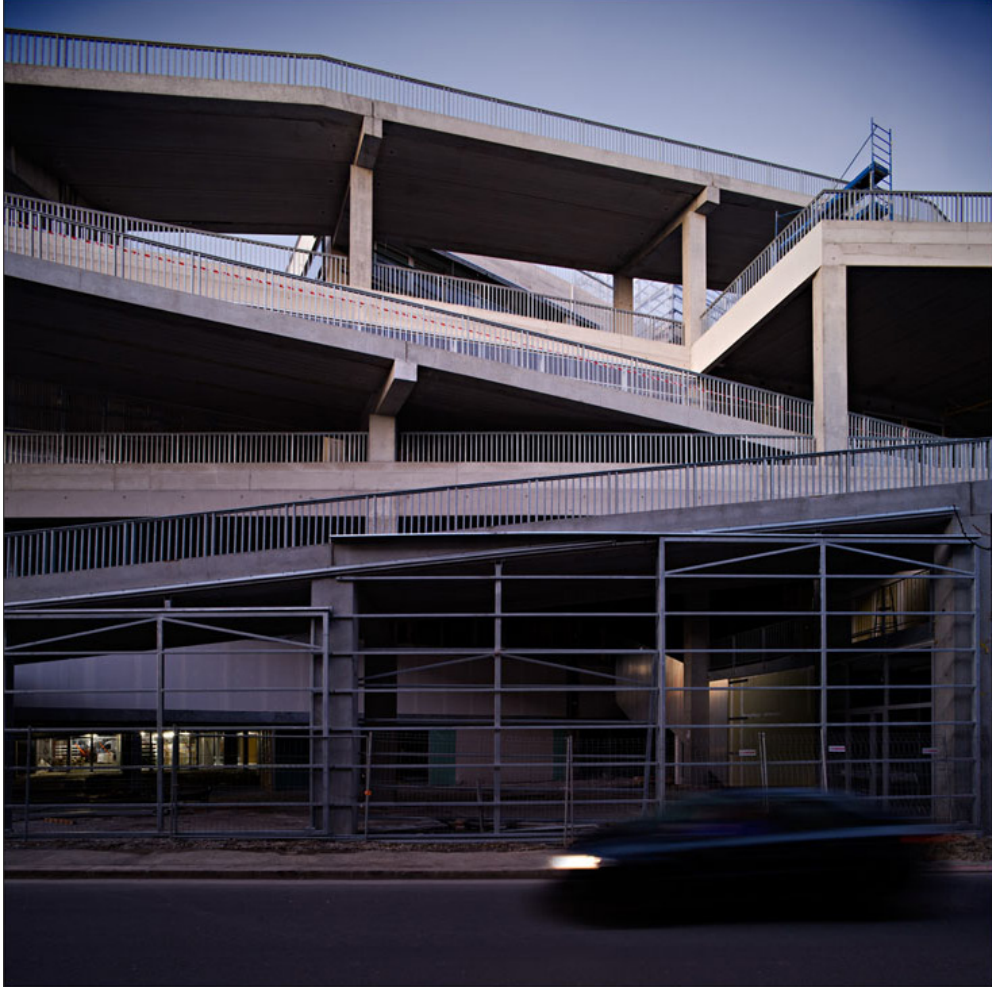
FIGURA 4. ANNE LACATON Y JEAN-PHILIPPE VASSAL, ESCUELA DE ARQUITECTURA DE NANTES EN CONSTRUCCIÓN, 2003-2008. Fotografía Javier Callejas
