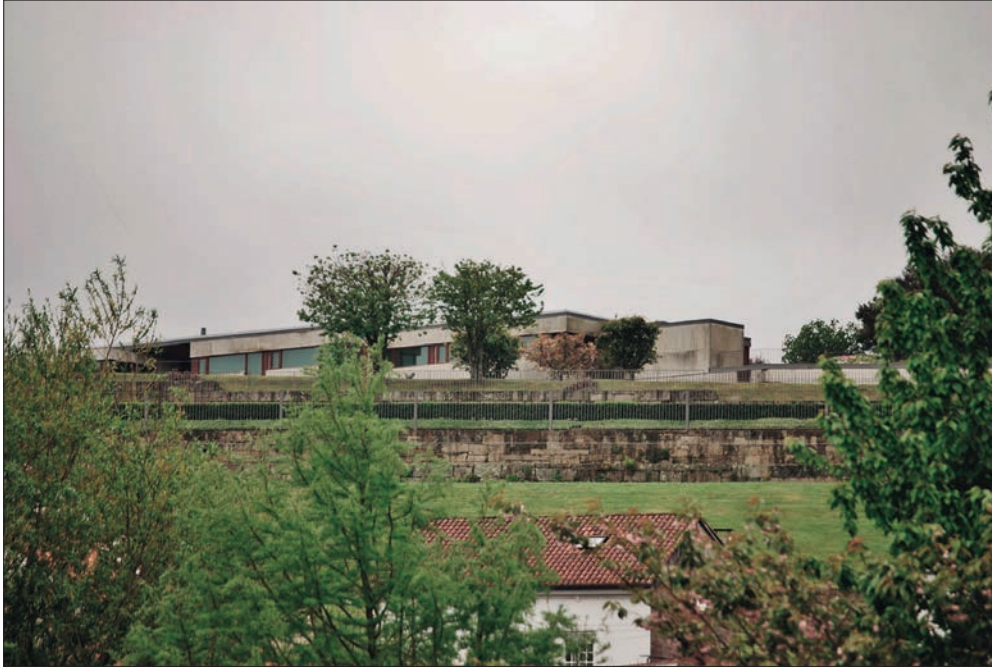
FIGURA 16. MANUEL GALLEGO, COMPLEJO PRESIDENCIAL DE LA XUNTA DE GALICIA. VISTA DESDE LA BASE DE MONTE PÍO. Fotografía del autor
