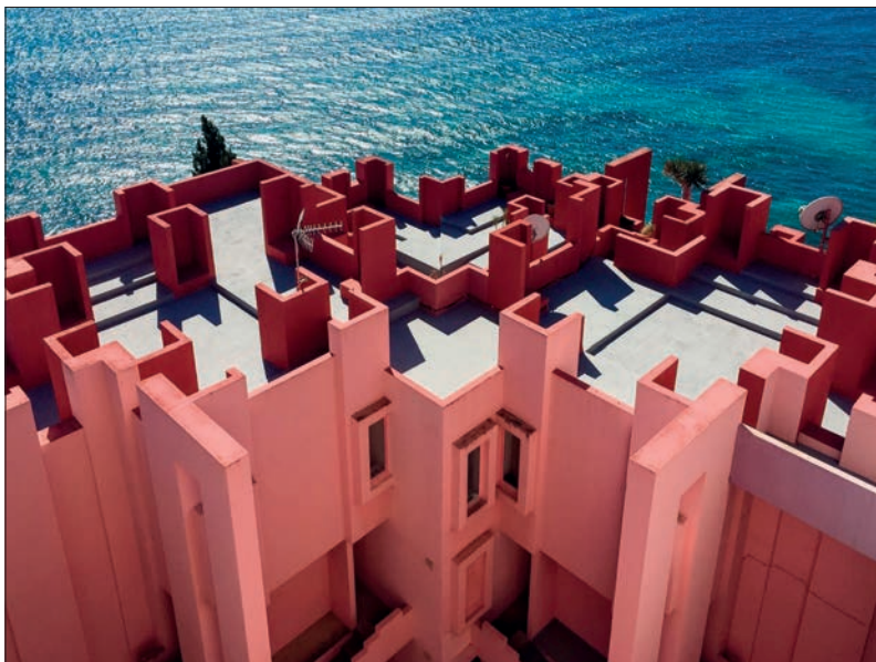
FIGURA 5. VISTA AÉREA DE LA MURALLA ROJA. Fuente: Fernando Cabalo
