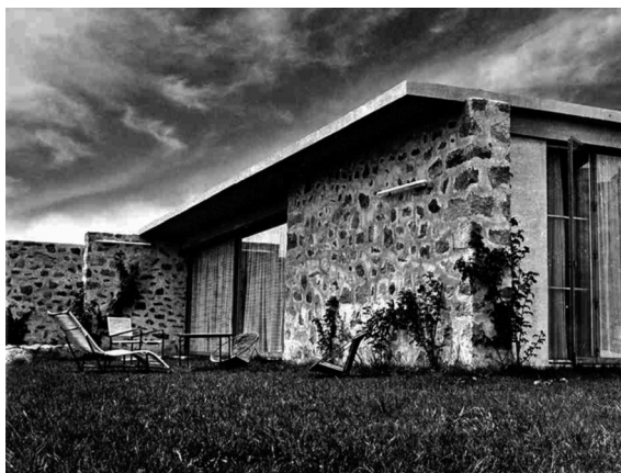
Fig. 11. Vivienda de Miguel Fisac en el Cerro del Aire (Madrid): fachada sur. Foto: Fundación Miguel Fisac.
