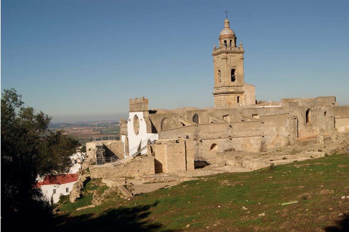
FIGURA 4. IGLESIA S. XVI-XVII Intervenciones inadecuadas que introducen falsificación histórica y estética.
