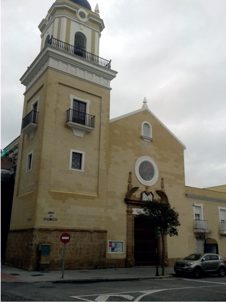
FIGURA 3: OBRAS DE REVESTIMIENTO DE PLACAS PÉTREAS CONTEMPORÁNEAS CON EL OBJETIVO DE BUSCAR UNA MAYOR EFICACIA EN LA CONSERVACIÓN DEL EDIFICIO.
