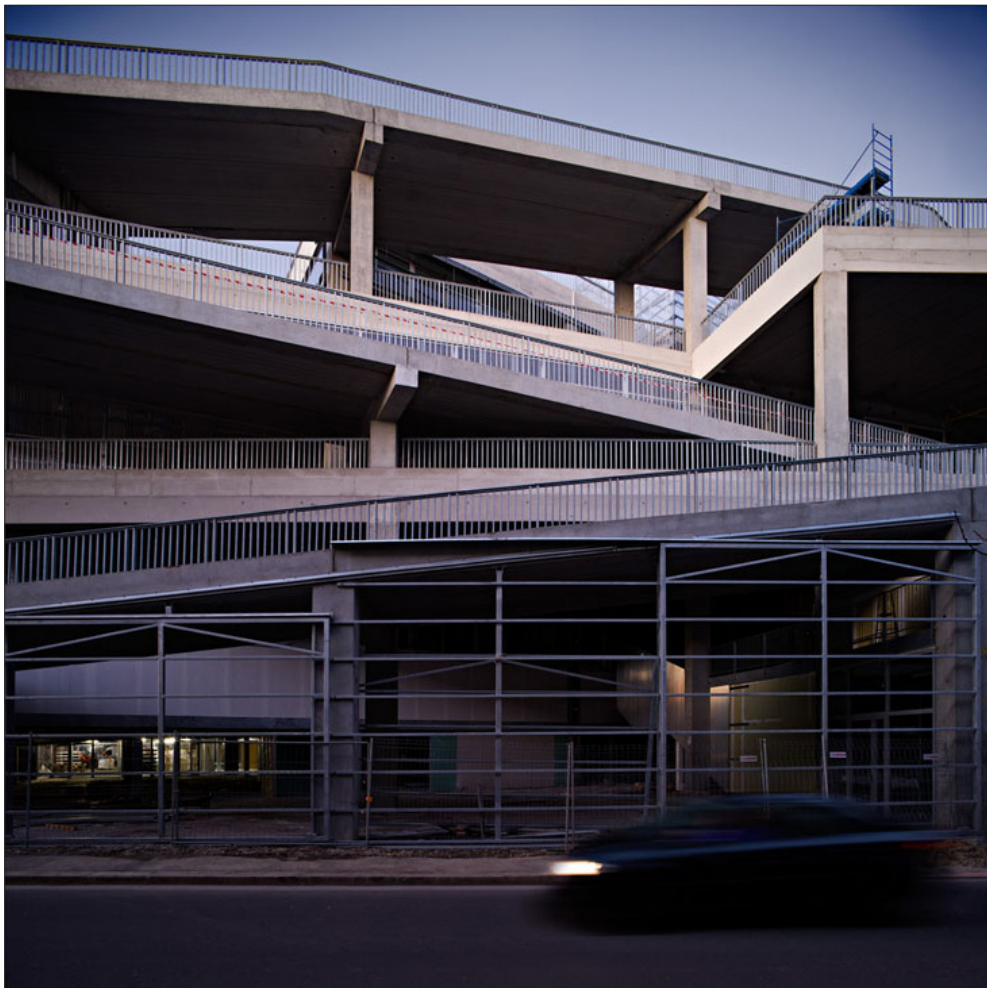
FIGURA 4. ANNE LACATON Y JEAN-PHILIPPE VASSAL, ESCUELA DE ARQUITECTURA DE NANTES EN CONSTRUCCIÓN, 2003-2008. Fotografía Javier Callejas
