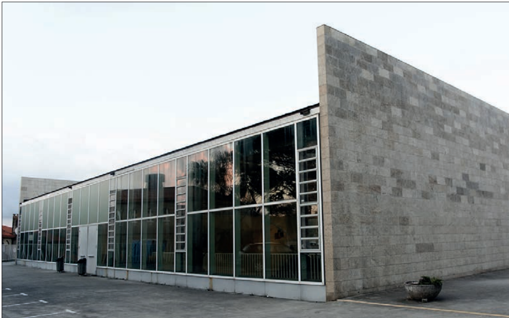
FIGURA 12. JOSEF PAUL KLEIHUES, POLIDEPORTIVO DE SAN CLEMENTE (SANTIAGO DE COMPOSTELA). Fotografía del autor
