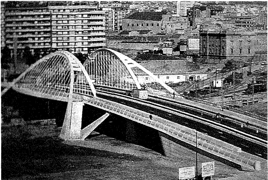
Fig. 8. Puente de Bach de Roda, Barcelona (España), 1984-1987.
