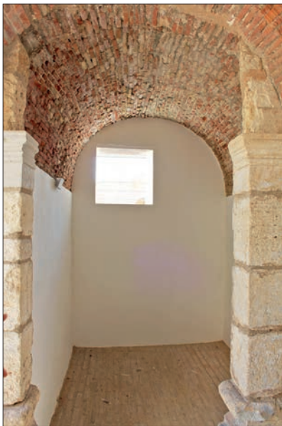
FIGURA 4: ASPECTO INTERIOR DEL REPUESTO DESPUÉS DE LA INTERVENCIÓN, 2011. Fotografía del autor.
