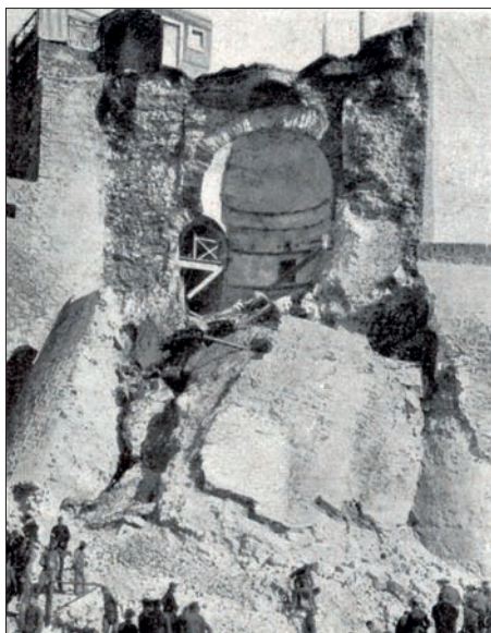
FIGURA 16. FOTOGRAFÍA DEL DERRUMBE DEL TORREÓN DE LAS CABRAS. REVISTA BLANCO Y NEGRO DE 13 DE MARZO DE 1927.
