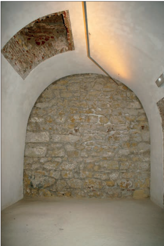
FIGURAS 8 Y 9. INTERIOR DEL REPUESTO DE PÓLVORA DE VICTORIA GRANDE, ANTES DE LA INTERVENCIÓN, 2010, Y EN 2018. Fotografías del autor.
