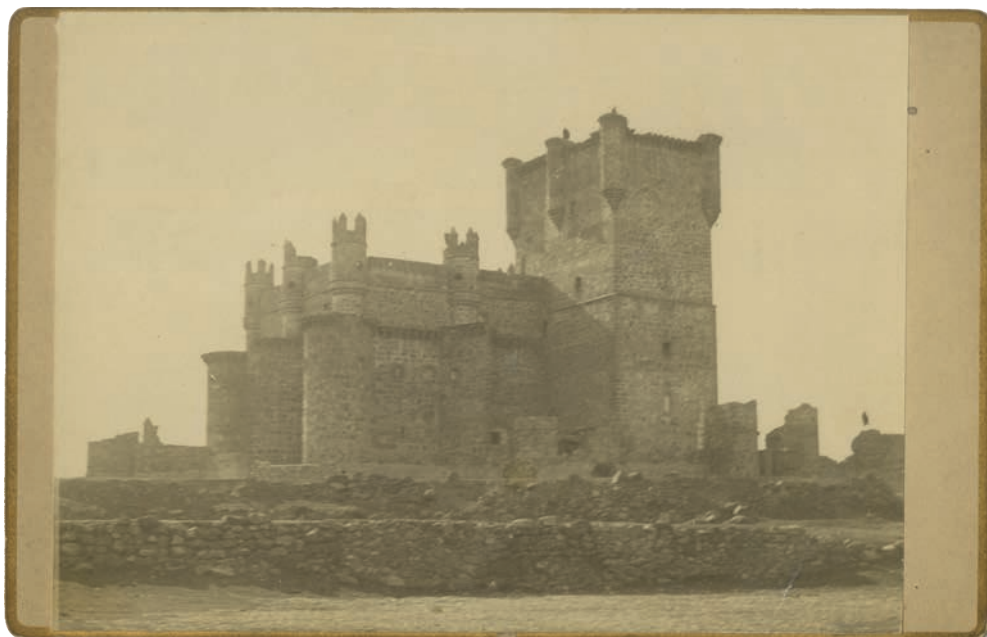
FIGURA 5. ESTADO EXTERIOR DEL CASTILLO ANTES DE INICIARSE LAS OBRAS DE RESTAURACIÓN. FONDO CONDES DE PEÑALVER, C.2, D. 200.
