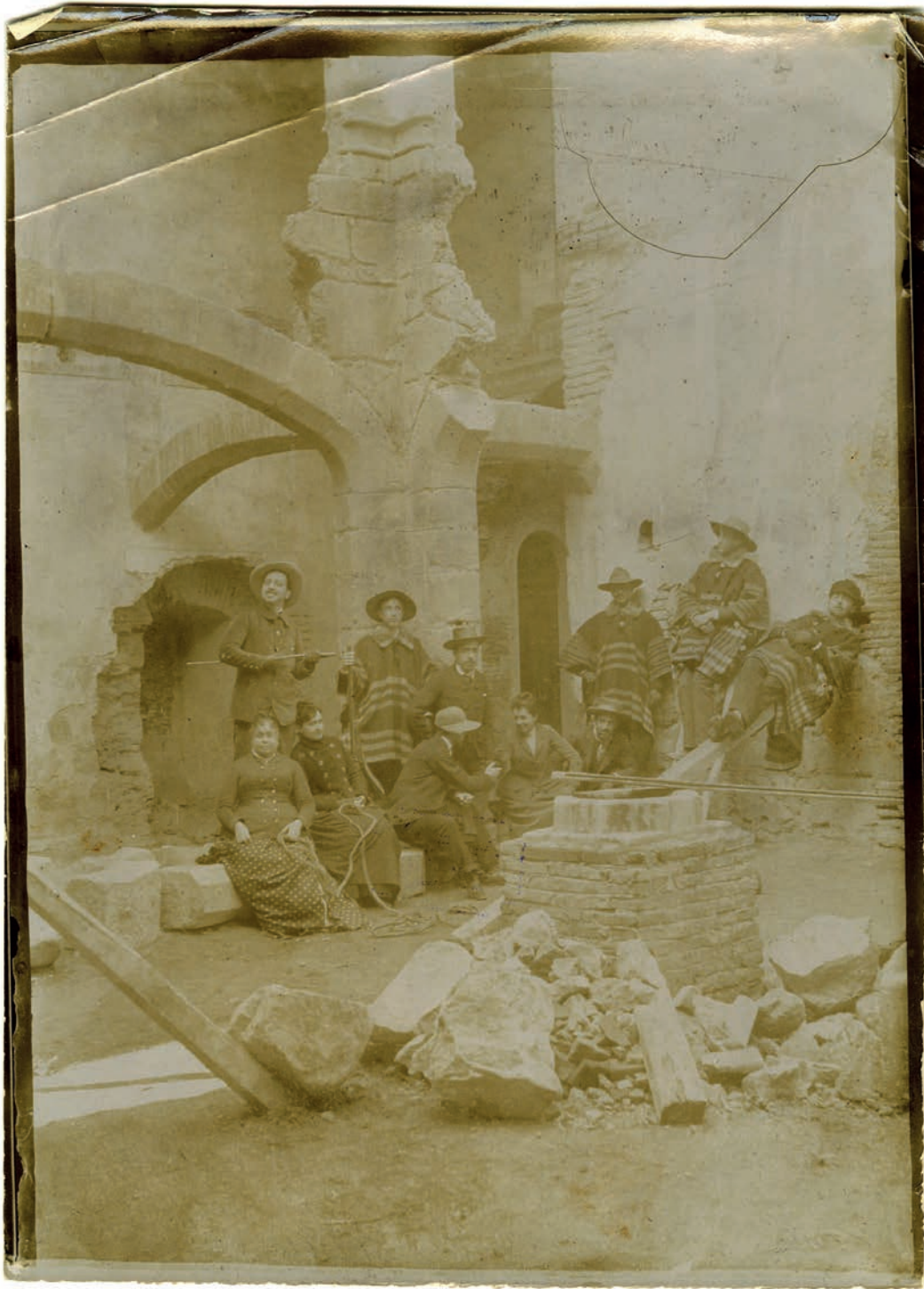
FIGURA 6. IMAGEN DEL PATIO INTERIOR CON ALGUNOS MIEMBROS DE LA FAMILIA DEL CONDE ANTES DE INICIARSE LAS OBRAS DE RESTAURACIÓN. SE TRATA DE UN DOCUMENTO DE GRAN VALOR, PUES HASTA DONDE TENEMOS CONSTANCIA SERÍA LA ÚNICA FOTOGRAFÍA QUE EXISTE DEL INTERIOR DEL MONUMENTO PREVIO A SU RESTAURACIÓN. FONDO CONDES DE PEÑALVER, C.2, D. 206.
