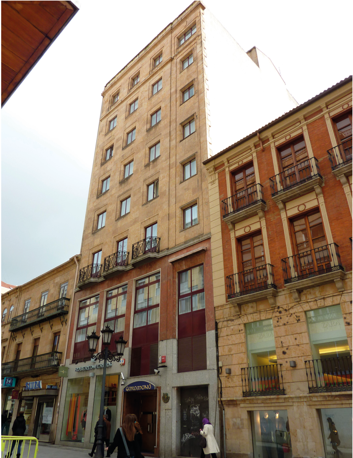
FIGURA 5. FACHADA DEL EDIFICIO DE FRANCISCO GIL (1957), ANTIGUO HOTEL ALFONSO X CALLE TORO. FRANCISCO GIL GONZÁLEZ. IMAGEN DEL AUTOR.
