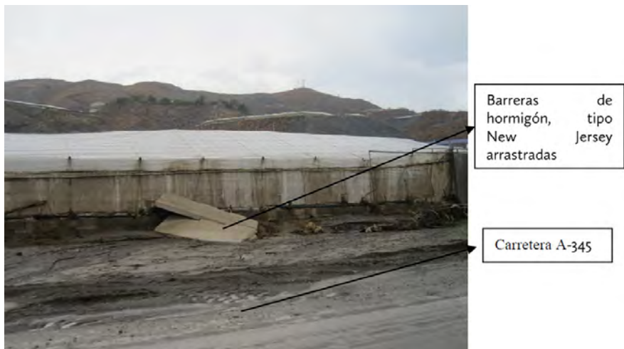
IMAGEN NÚMERO 13.- BARRERAS DE HORMIGÓN, TIPO NEW JERSEY, UTILIZADAS PARA LAS OBRAS DE CARRETERAS Y CON UN PESO APROXIMADO SUPERIOR A LOS 500 KGS. Autor: José Ramón Sánchez Holgado.
