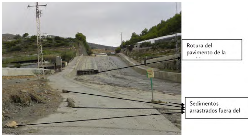
IMAGEN NÚMERO 3.- DAÑOS OCASIONADOS EN LA RAMBLA ALDAHAYAR DURANTE LAS LLUVIAS DEL DÍA 07 DE SEPTIEMBRE DEL 2015. Autor: José Ramón Sánchez Holgado.
