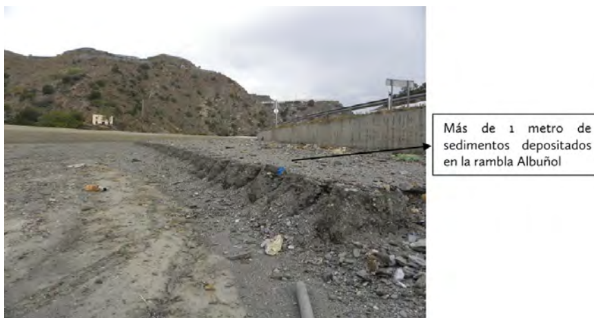
IMAGEN NÚMERO 8.- FOTO CAPTADA DESDE EL INTERIOR DEL CAUCE DE LA RAMBLA. SE APRECIA COMO LA INERCIA DE LA VELOCIDAD DEL AGUA SE CIÑÓ SOBRE EL MARGEN DERECHO DEL CAUCE, SOBREPASANDO EL MURO DE CONTENCIÓN (4 METROS), DEPOSITANDO TONELADAS DE SEDIMENTOS EN EL MARGEN IZQUIERDO, QUE SUPERAN EL METRO DE ALTURA. Autor: José Ramón Sánchez Holgado.
