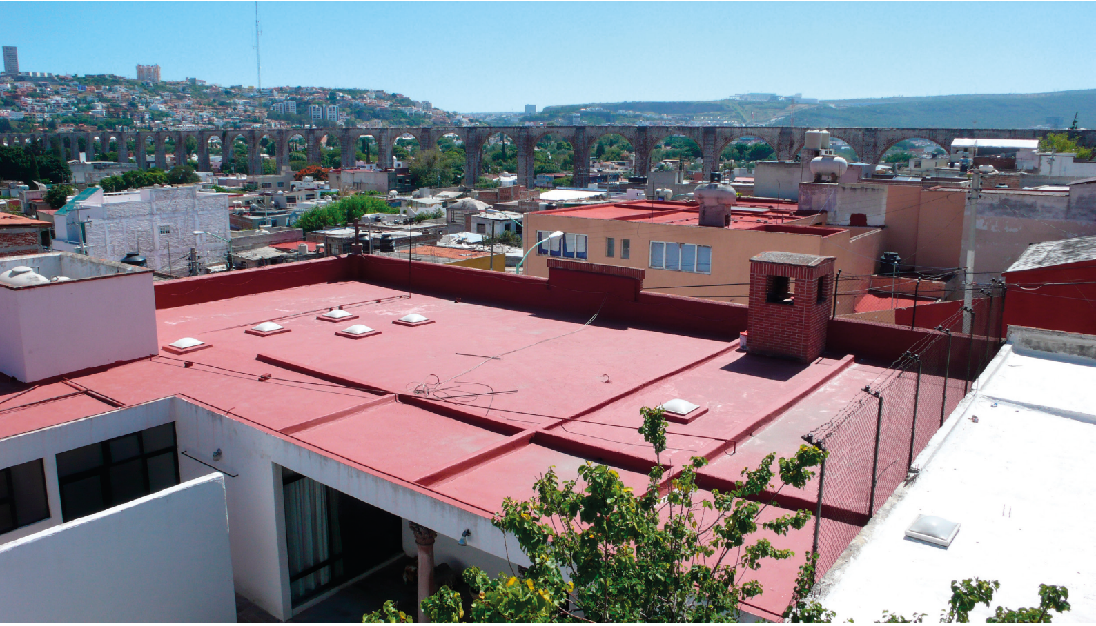
FIGURA 5. QUERETARO. VIVIENDAS DE INTERÉS SOCIAL Foto A. Zárate.
