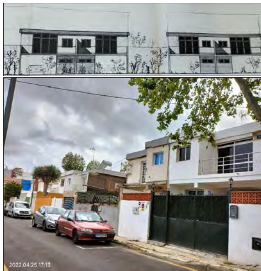
FIGURA 32. 12 APARTAMENTOS PARA LA COMUNIDAD DE BIENES LA CANDIA, 1964. Fuente: AMLL, 807-297; 801-21 FIGURA 33. Fuente: M. Arranz, 2022
