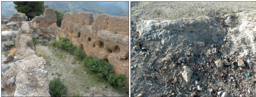
FIGURAS 3 Y 4.- CASTILLEJO DE LOS GUÁJARES Y EN LA IMAGEN DE LA DERECHA, LOS POSIBLES RESTOS DEL CASTILLO DE GUÁJAR LA VIEJA (PENDIENTE DE DATACIÓN). Autor: José Ramón Sánchez Holgado.
