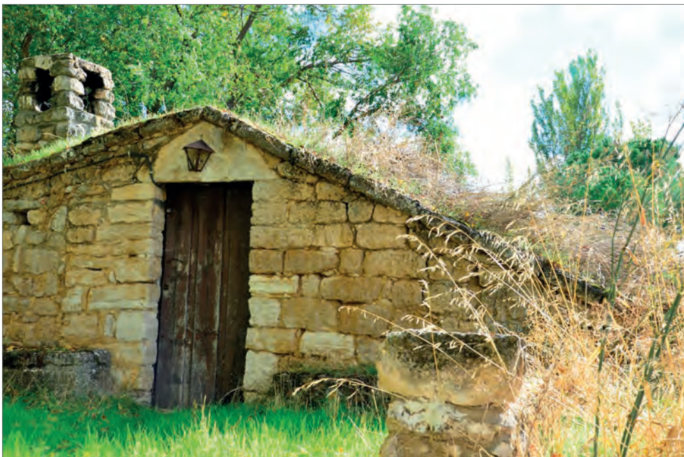
FIGURA 5. BARRIO DE BODEGAS DE FUENSALDAÑA Y FIGURA 6. BODEGA EN CUBILLAS DE SANTA MARTA. Fuente: Elaboración propia.
