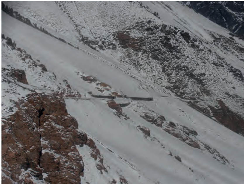
FIGURA 10. SECTOR DEL TRAMO CHILENO DEL FERROCARRIL TRASANDINO EN UNA PRONUNCIADA LADERA DEL VALLE DEL JUNCAL. Fotografía: Julio López-Davalillo Larrea.
