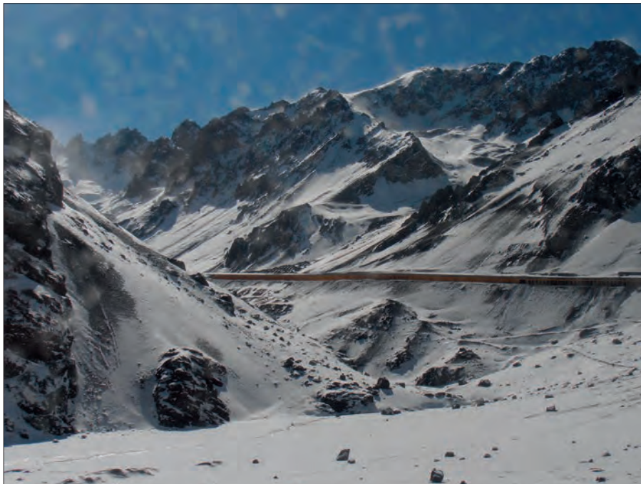
FIGURA 5. EN ALGUNOS TRAMOS LA CARRETERA DEL PASO LIBERTADORES, ASÍ COMO EL FERROCARRIL TRASANDINO, SE ENCUENTRA PROTEGIDA POR PARAPETOS Y CORREDORES TECHADOS DE HORMIGÓN A CIELO ABIERTO PARA PREVENIR LAS AVALANCHAS DE NIEVE Y ROCAS. Fotografía: Julio López-Davalillo Larrea.
