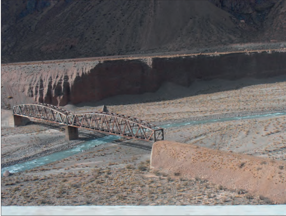
FIGURA 9. PUENTE DE HIERRO APOYADO EN PILARES DE PIEDRA SOBRE EL RÍO MENDOZA DEL HOY ABANDONADO FERROCARRIL TRASANDINO. Fotografía: Julio López-Davalillo Larrea.
