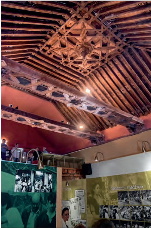
FIGURA 9: ERMITA DE LOS REMEDIOS. TECHO MUDÉJAR. Fotografía Aurelio Cebrián.
