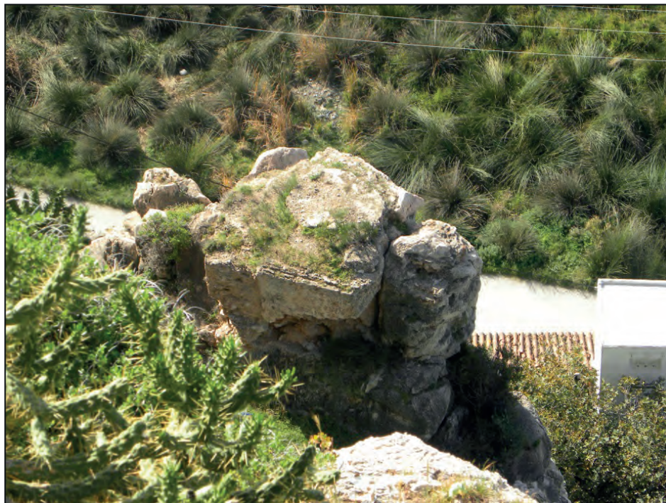
FIGURA NÚMERO 21.- RESTOS DE UNA ANTIGUA TORRE, DE AL MENOS DOS EXISTENTES, QUE CUSTODIABA LA LLEGADA DE EMBARCACIONES Y EL ACCESO AL CAMINO DEL CASTILLO. Autor: José Ramón Sánchez Holgado.
