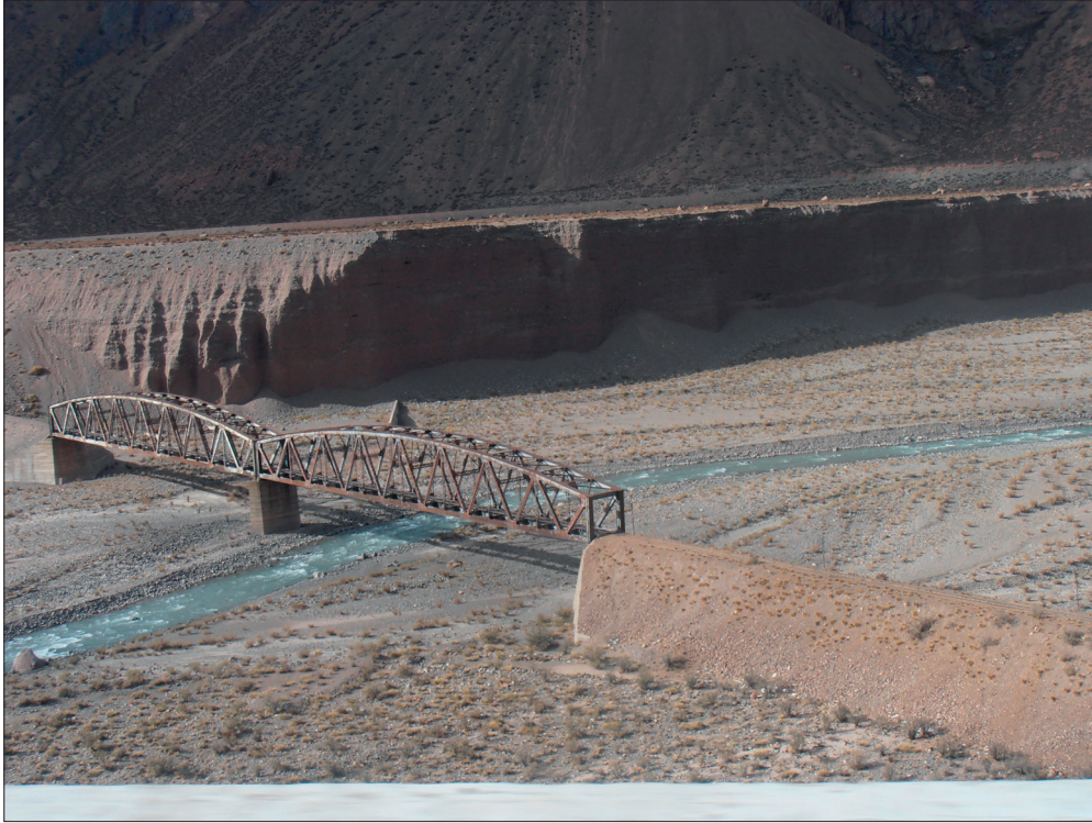
FIGURA 9. PUENTE DE HIERRO APOYADO EN PILARES DE PIEDRA SOBRE EL RÍO MENDOZA DEL HOY ABANDONADO FERROCARRIL TRASANDINO. Fotografía: Julio López-Davalillo Larrea.
