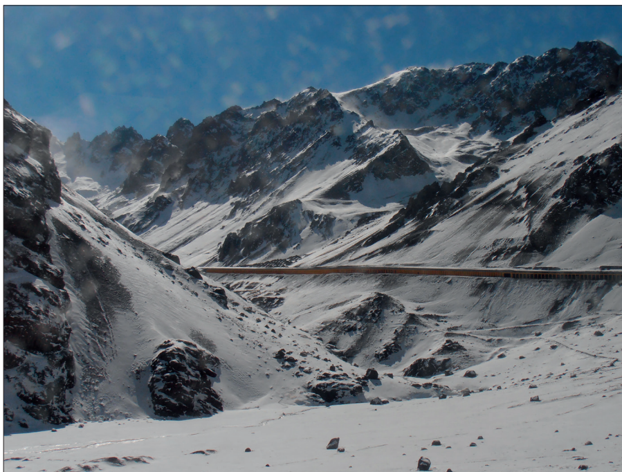
FIGURA 5. EN ALGUNOS TRAMOS LA CARRETERA DEL PASO LIBERTADORES, ASÍ COMO EL FERROCARRIL TRASANDINO, SE ENCUENTRA PROTEGIDA POR PARAPETOS Y CORREDORES TECHADOS DE HORMIGÓN A CIELO ABIERTO PARA PREVENIR LAS AVALANCHAS DE NIEVE Y ROCAS. Fotografía: Julio López-Davalillo Larrea.
