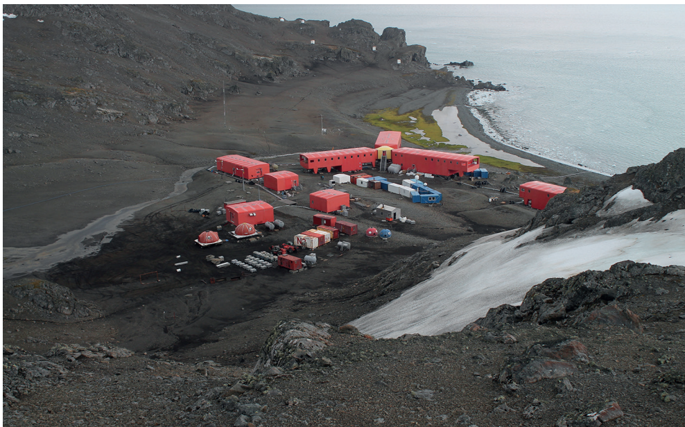
DETALLE DE LA BASE ANTÁRTICA ESPAÑOLA JUAN CARLOS I EN LA ISLA LIVINGSTON EN FEBRERO DE 2017. SE OBSERVAN LOS MÓDULOS DE LA NUEVA BASE JUNTO A DIVERSOS CONTENEDORES Y EDIFICACIONES DE LA BASE ANTIGUA, QUE SERÁN RETIRADOS EN LA CAMPAÑA ANTÁRTICA DE 2018. TAMBIÉN SON VISIBLES DIVERSOS NIVELES DE PLAYAS LEVANTADAS, ALGUNO DE LOS CUALES ESTÁ CUBIERTO POR DENSAS ALFOMBRAS DE MUSGOS.
