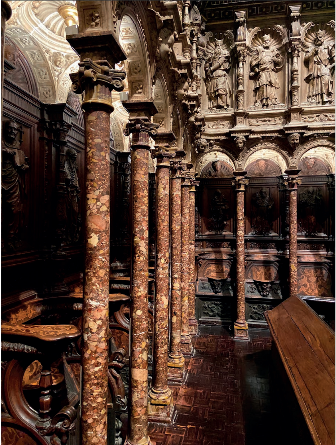
FIGURA 1. DETALLE DEL CONGLOMERADO DE ESPEJÓN UTILIZADO EN EL CORO DE SILLAS DE LA CATEDRAL DE TOLEDO. Fotografía de la autora
