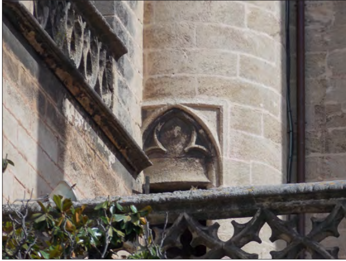
FIGURA 4. ALFIZ ENCUADRANDO LA PUERTA DE SALIDA A LAS CUBIERTAS DE LA CAPILLA DE SAN LAUREANO. Catedral de Sevilla
