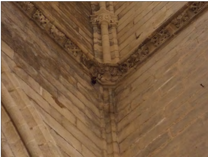
FIGURA 5. MÉNSULA VOLADA RECOGIENDO UN BAQUETÓN ENTRE LA CAPILLA DE SAN LAUREANO Y LA NAVE DE SAN ROQUE. Catedral de Sevilla
