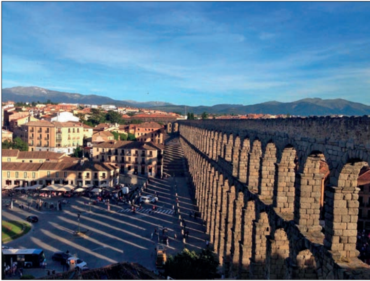
FIGURA 4. ACUEDUCTO ROMANO DE SEGOVIA. ES LA PARTE FINAL DE LA LLAMADA CACERA REAL, QUE SUMINISTRABA AGUA A LA CIUDAD Y AL ALCÁZAR DEL REY DESDE LA SIERRA. FOTO DE LOS AUTORES.
