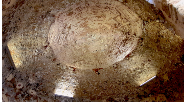
FIGURA 6. NIEBLA, ÚLTIMO TERCIO DEL SIGLO XV. ALCÁZAR DE LOS GUZMÁN, BÓVEDA ENCOFRADA DE LA TORRE POLIGONAL SUROCCIDENTAL. Fotografía del autor
