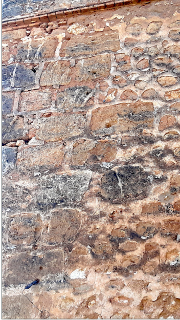
FIGURA 5. NIEBLA, ÚLTIMO TERCIO DEL SIGLO XV. ALCÁZAR DE LOS GUZMÁN, DETALLE DEL APAREJO DE UNA DE LAS TORRES. Fotografía del autor
