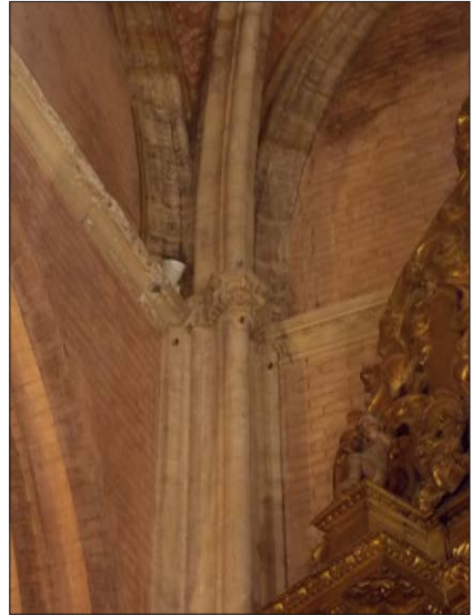
FIGURA 6. BAQUETÓN UBICADO EN LA PRIMERA BÓVEDA DE LA NAVE DE LA EPÍSTOLA. Prioral de Santa María de Carmona (Sevilla)
