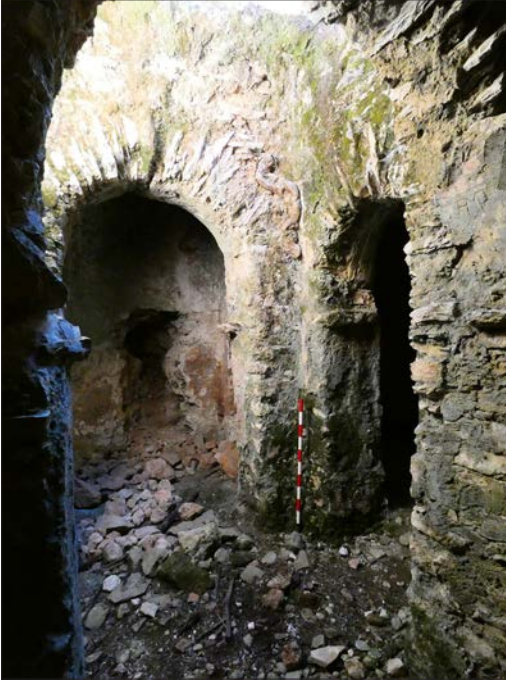
FIGURA 5: INTERIOR DEL ALJIBE. Foto del autor
