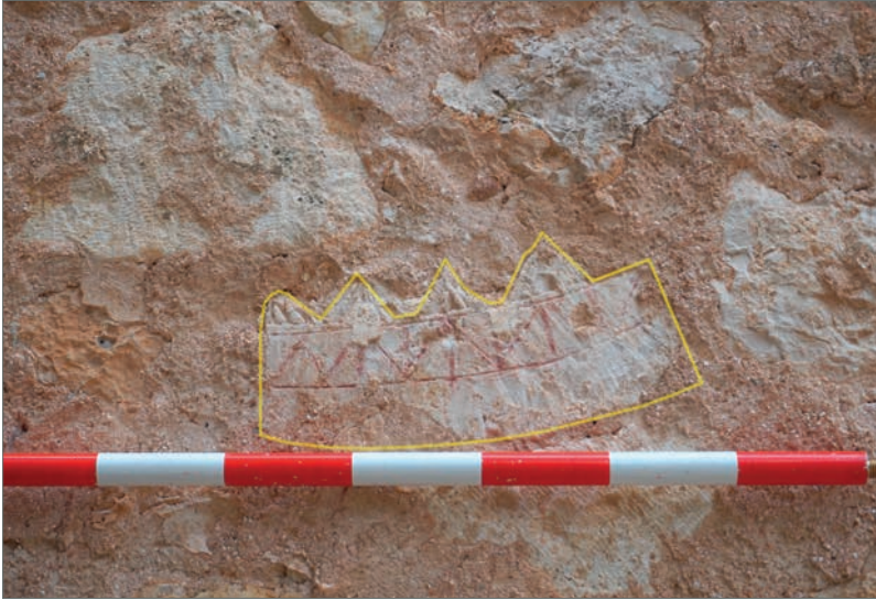
FIGURA 12. POSIBLES RESTOS DE LA DECORACIÓN DE LA IGLESIA EMBUTIDOS EN EL MURO SEPTENTRIONAL DEL PANTEÓN ACTUAL. EN AMARILLO SE HA REMARCADO LA SILUETA DE LA PIEZA. Fotografía del autor.
