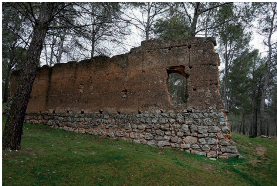
FIGURA 7. MURO CONSERVADO AL OESTE DEL ACTUAL CEMENTERIO, PERTENECIENTE AL EDIFICIO DEL HOSPITAL SEGÚN NUESTRA INTERPRETACIÓN.
