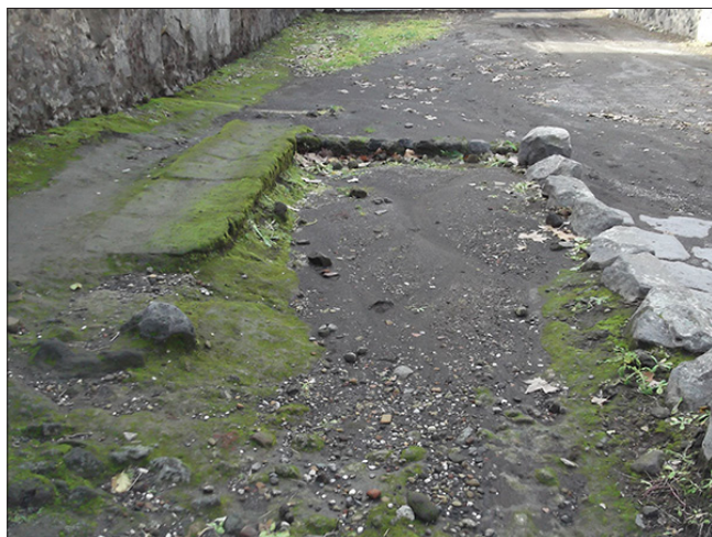
FIGURA 10. ACERA CON DESAGÜE DE LA VILLA DI DIOMEDE. VIA DEI SEPOLCRI. Foto: Autora, 2014
