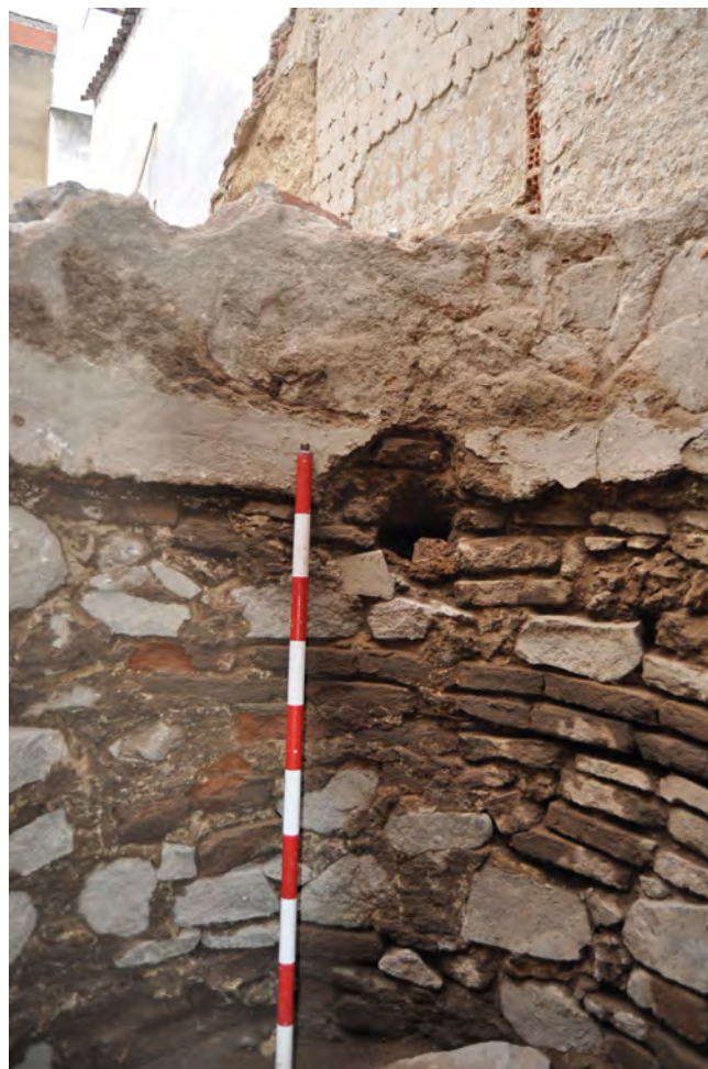
FIG. 7. ALZADO DE LOS ALVEI DEL CALDARIUM. (Fotografía de la autora).
