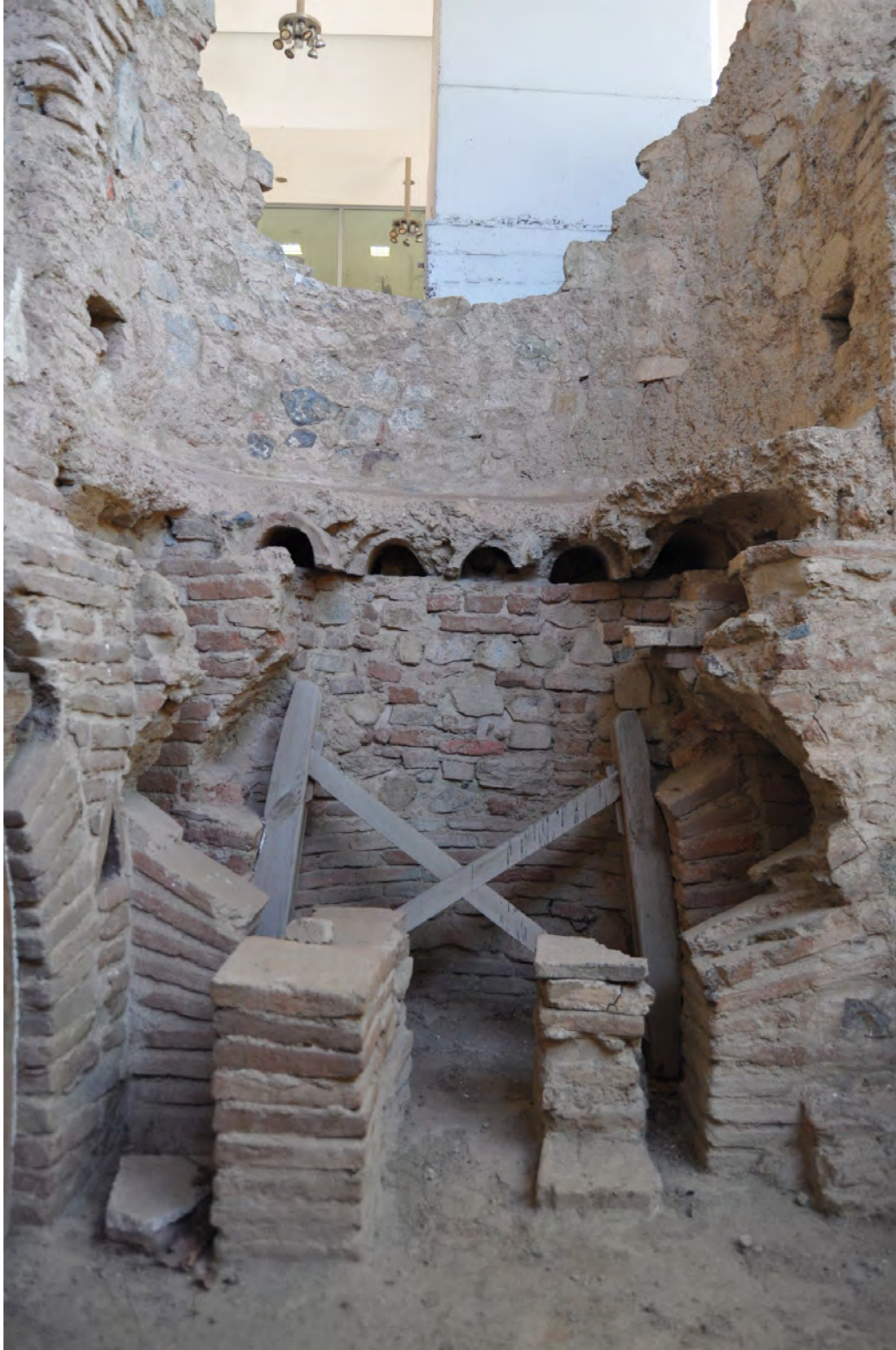
FIG. 16. SISTEMA DE SUSPENSURA Y CONSTRUCCIÓN DE LOS SUELOS DEL TEPIDARIUM DE MORERÍA, MÉRIDA. (Fotografía de la autora).
