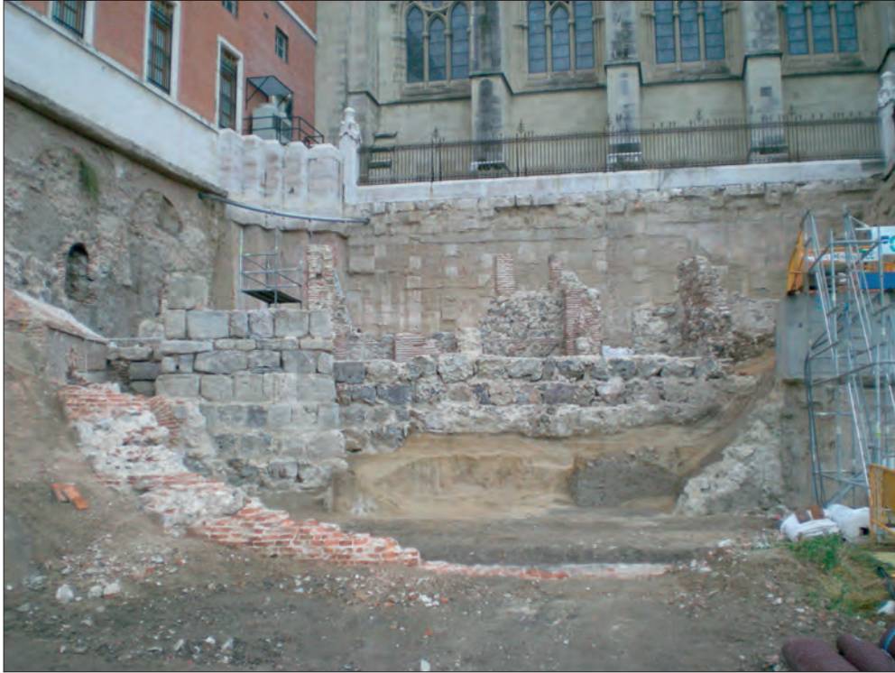
FIG. 6. ARMERÍA, TORRE DE FLANQUEO DE LA PUERTA DE LA SAGRA Y LIENZO. (Fotografía Arqueomedia).
