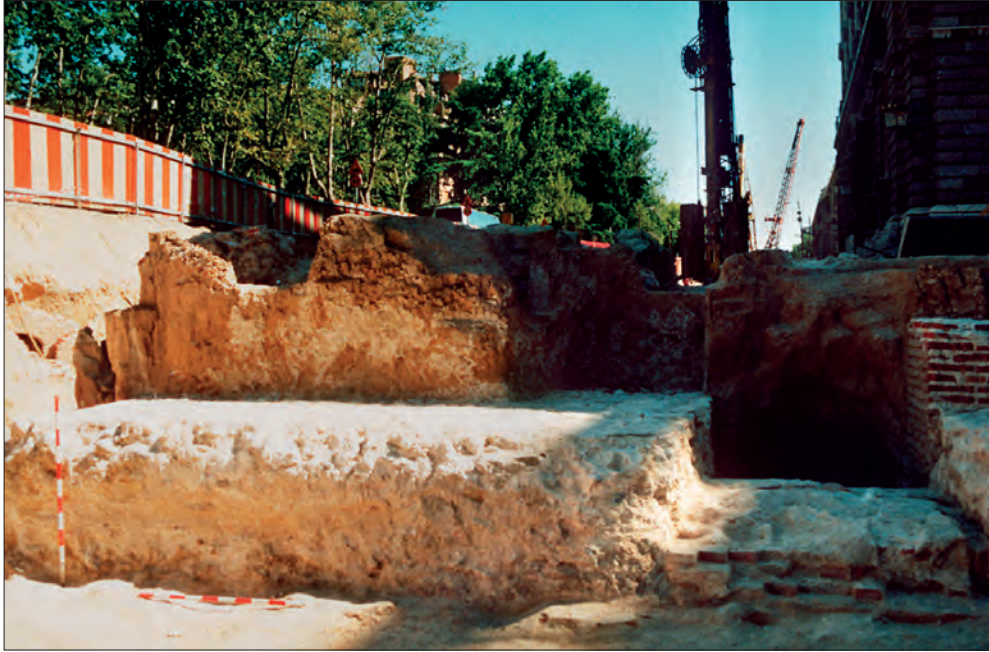
FIG. 8. AMPLIACIÓN DEL RECINTO EMIRAL. CIMENTACIÓN EN LA CALLE BAILÉN. (Fotografía Arqueomedia).
