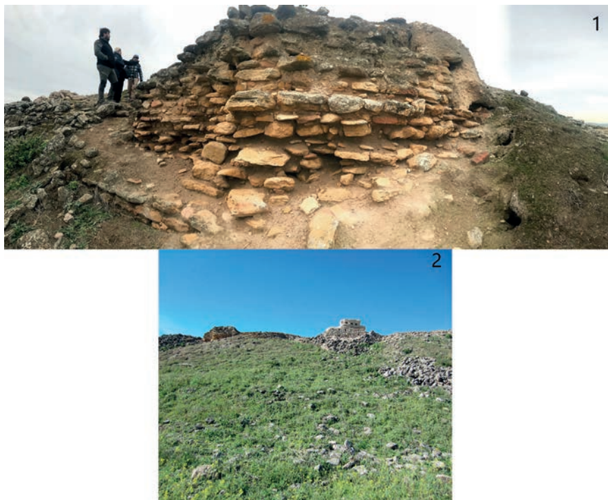
FIGURA 14. 1. TRAMO DE LA CERCA ORIENTAL DE LA FORTALEZA TARDO-ISLÁMICA ANTES DE LA CONSOLIDACIÓN. © I. Carrasco 2. DESDE EL SUELO DEL YACIMIENTO VISTA DE LOS DOS TRAMOS EN ALZADO DEL LADO ORIENTAL DE LA CERCA TARDO-ISLÁMICA. © M. a C. Fuertes
