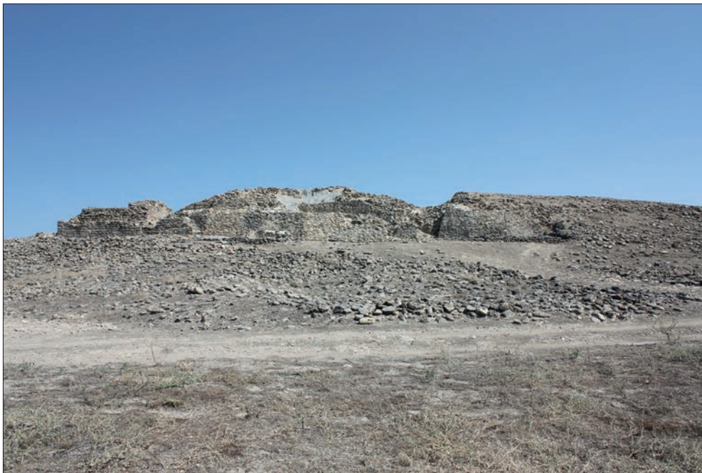
FIGURA 15. FRENTE OCCIDENTAL DE LA ACRÓPOLIS TRAS LAS OBRAS DE RESTAURACIÓN Y CONSOLIDACIÓN. © M.ª C. Fuertes
