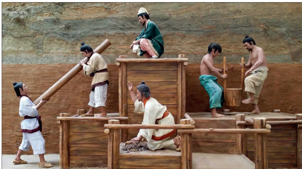
FIGURA 10: RECREACIÓN DE LAS OBRAS DE CONSTRUCCIÓN DE UNA MURALLA DE TIERRA COMPACTADA. (Seoul Baekje Museum, vestíbulo de la planta baja, de http://www.1-2-3-korea.com/ ).
