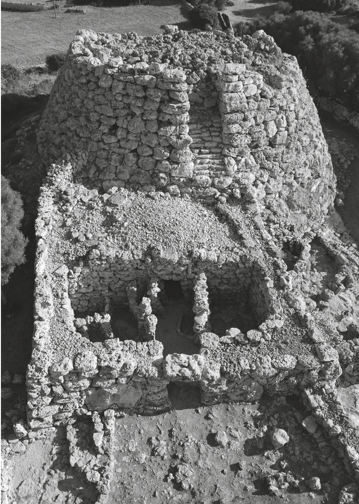
FIGURA 5. VISTA AÉREA DEL TALAYOT OESTE, CON EL EDIFICIO ADOSADO YA EXCAVADO
